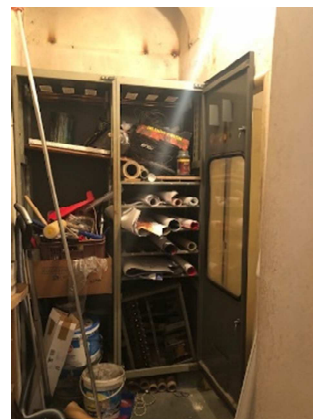
Obrázek 13 - původní stav "rozvodny"
