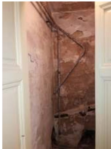
03, 04 - VÝSKYT VLHKOSTI V CELÉ MÍSTNOSTI, ZPŮSOBENO ABSENCÍ HYDROIZOLACE SKLEPNÍCH PROSTOR (ZA TOUTO MÍSTNOSTÍ SE NACHÁZÍ ZAZDĚNÉ SKLEPNÍ PROSTORY), ODPADÁVÁJÍCÍ OMÍTKA
