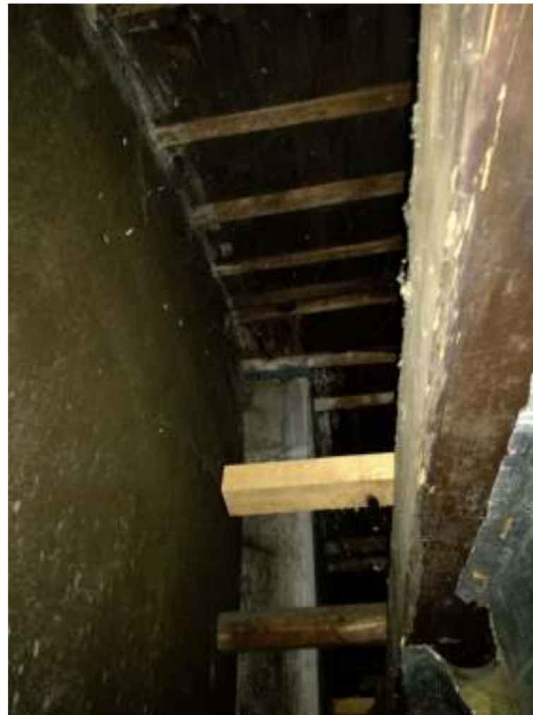
04 - NESPRÁVNĚ PROVEDENÁ REKONSTRUKCE STŘEŠNÍ ČÁSTI, PONECHÁNA PŮVODNÍ KRYTINA SLOUŽÍCÍ JAKO PODKLAD PRO NOVOU PLECH.KRYTINU
