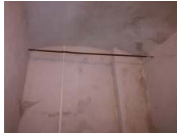
03, 04 - VÝSKYT VLHKOSTI V CELÉ MÍSTNOSTI, ZPŮSOBENO ABSENCÍ HYDROIZOLACE SKLEPNÍCH PROSTOR (ZA TOUTO MÍSTNOSTÍ SE NACHÁZÍ ZAZDĚNÉ SKLEPNÍ PROSTORY), ODPADÁVÁJÍCÍ OMÍTKA
