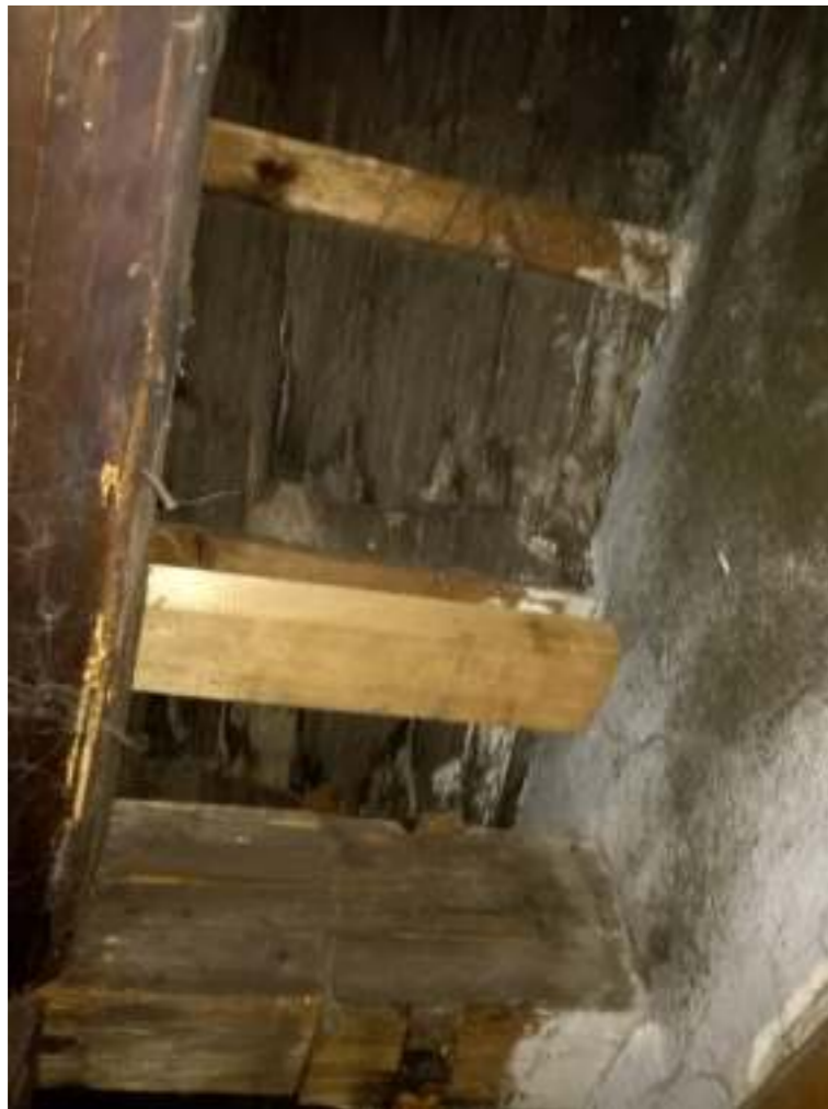
03 - ODPADÁVAJÍCÍ TEPELIZOLACE Z PŘEDSAZENÉ STĚNY
