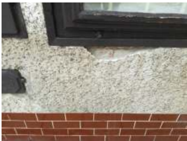
01 - NESOUDRŽNÁ OMÍTKA S PODKLADEM, VYPOUKLÁ ČÁST OMÍTKY
